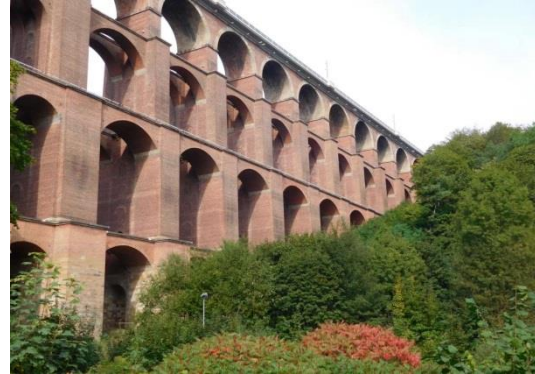
Abbildung 1 Göltzschtalbrücke bei Mylau
