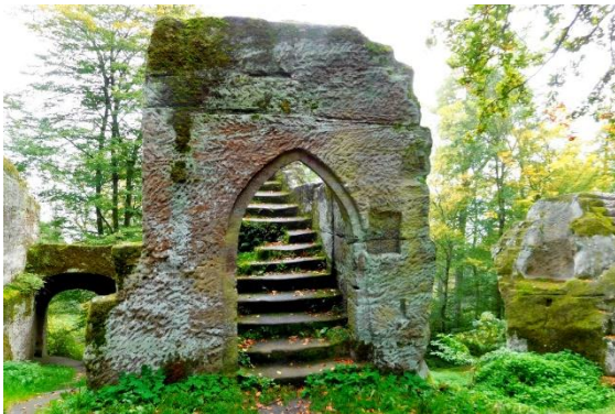
Abbildung 17 Burg Rothenhan, Torbau mit Treppe
